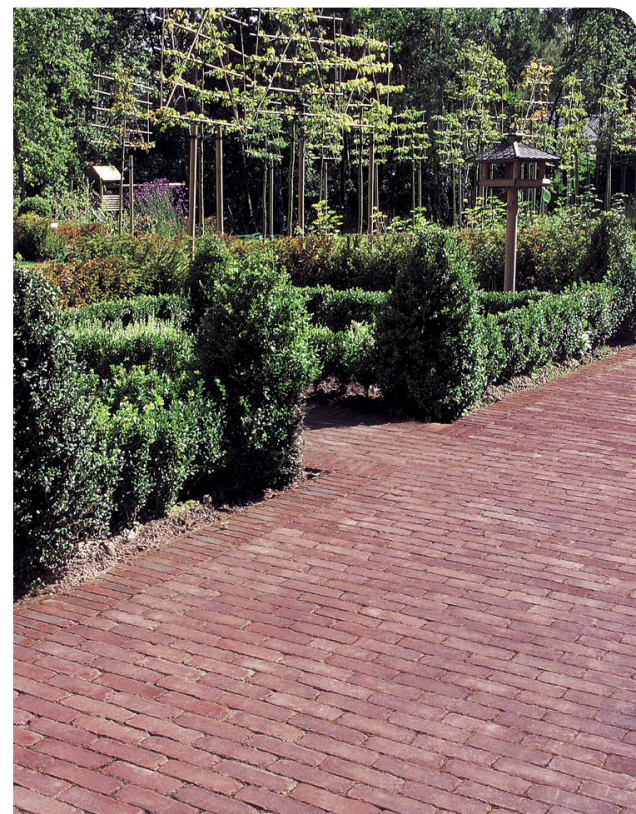
Voorbeeld(en) van straatbaksteen met daarin het coagulatieslib van Waternet
